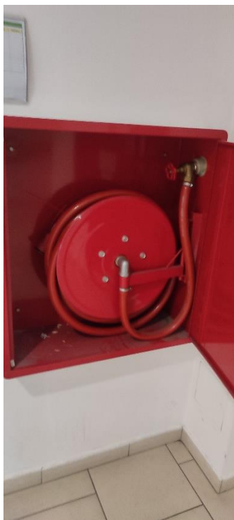
Hydrant wewnętrzny w budynku Akademii
